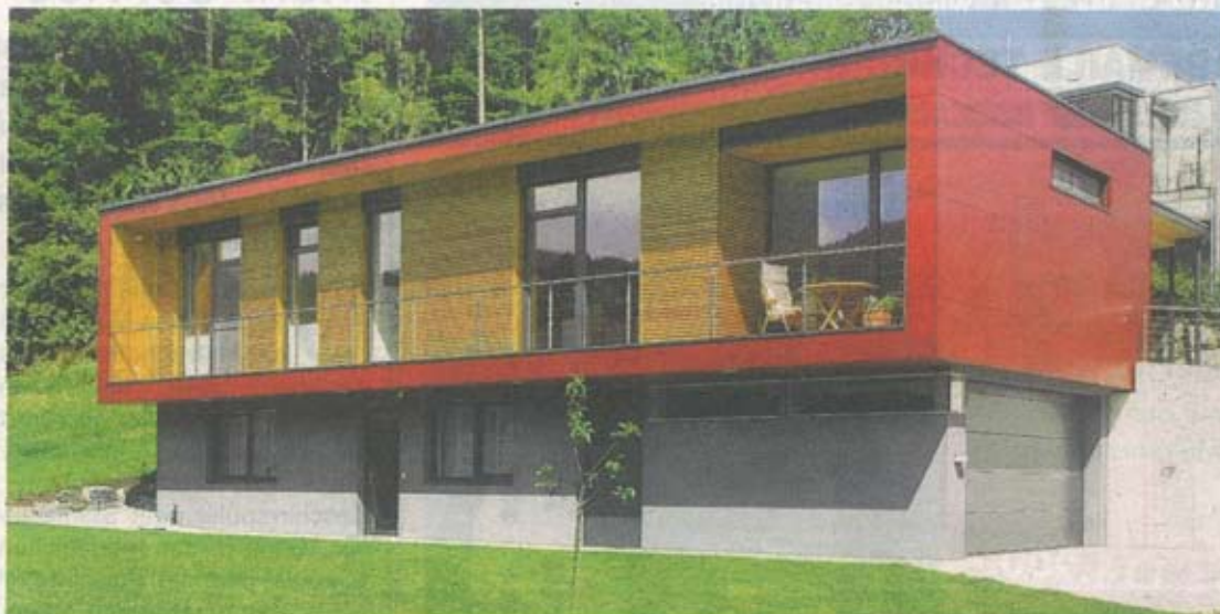
Ein Holzhaus hat viele Gesichter. Hier ist es mit roten Eternitplatten verkleidet. Planung: Transform Architekten Foto: Thery
