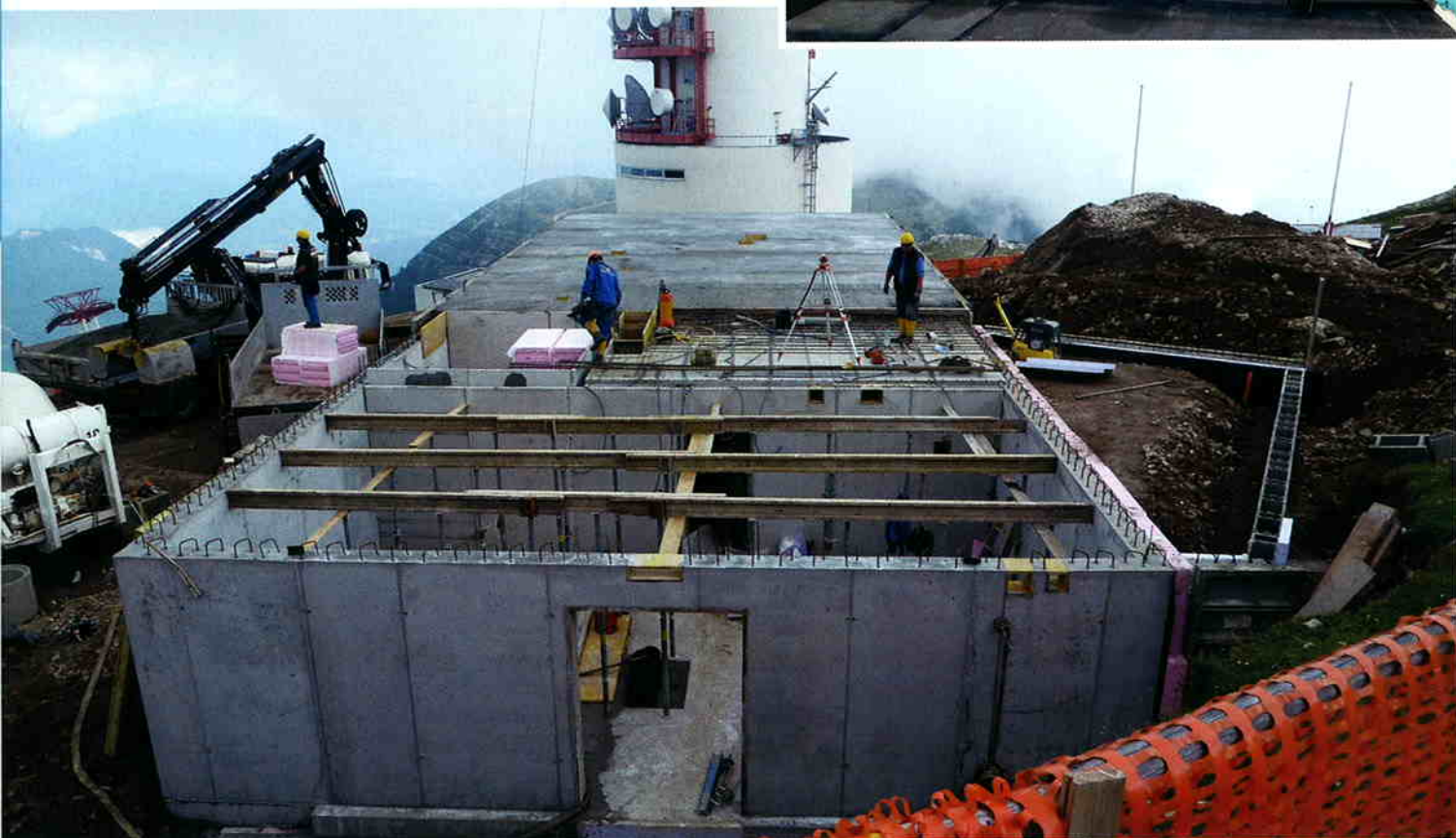
Das Untergeschoss in Massiv-Bauweise wurde in sechs Wochen errichtet. Der Beton musste vor Ort fertig abgemischt werden, da die steile Zufahrtsstraße für Mischwägen nicht befahrbar war.
