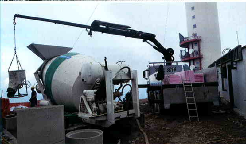
Das Untergeschoss in Massiv-Bauweise wurde in sechs Wochen errichtet. Der Beton musste vor Ort fertig abgemischt werden, da die steile Zufahrtsstraße für Mischwägen nicht befahrbar war.
