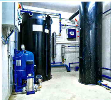
links: Eine Trinkwasseraufbereitungsanlage mit Grobfilter und UV-Anlage zur Entkeimung steht im Untergeschoss. rechts: Für alle Arbeitsschritte, wie hier dem Zusammensetzen der Fertigelemente, wurde ein penibler Zeitplan erstellt.
